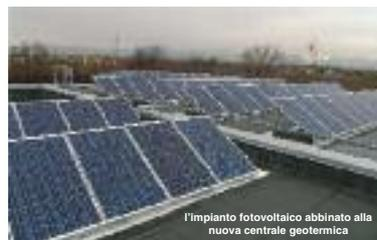
l'impianto fotovoltaico abbinato alla nuova centrale geotermica
