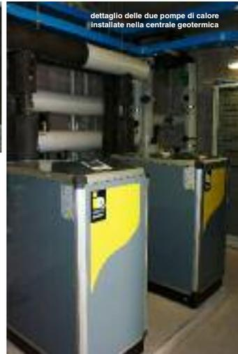
dettaglio delle due pompe di calore installate nella centrale geotermica
